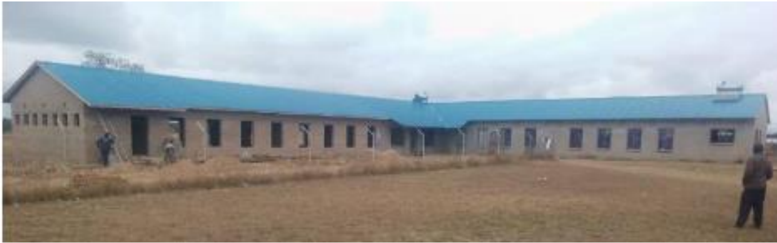
Neues Internat im Bau
